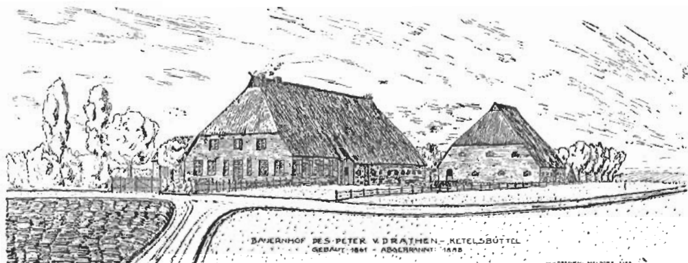
Hof in Ketelsbüttel.
