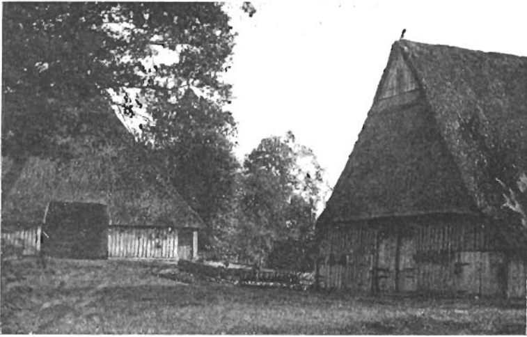
Hof am Lübnhuser Deich, Wirtschaftshof.
