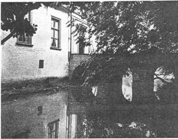
Leeuwen, Torhaus mit Graben und Brücke
